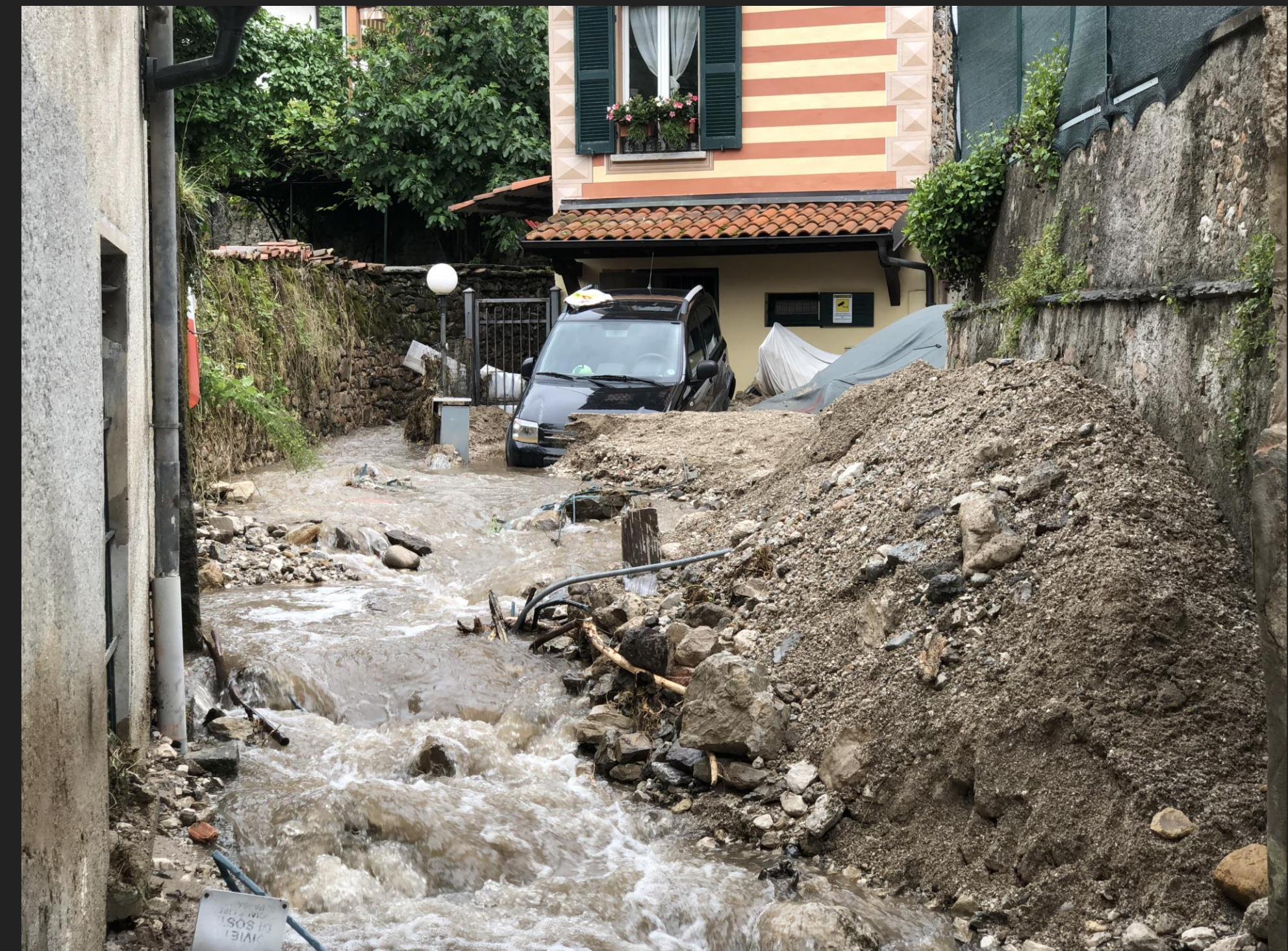
sottodimensionamento per mancata valutazione del trasporto solido
