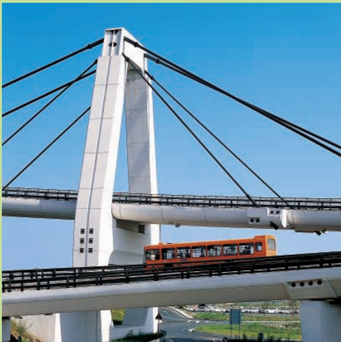
Infrastrutture mondiali: l'aeroporto di Malpensa, photo Paolo Zanzi. International infrastructure: the airport of Malpensa, photo by Paolo Zanzi.
